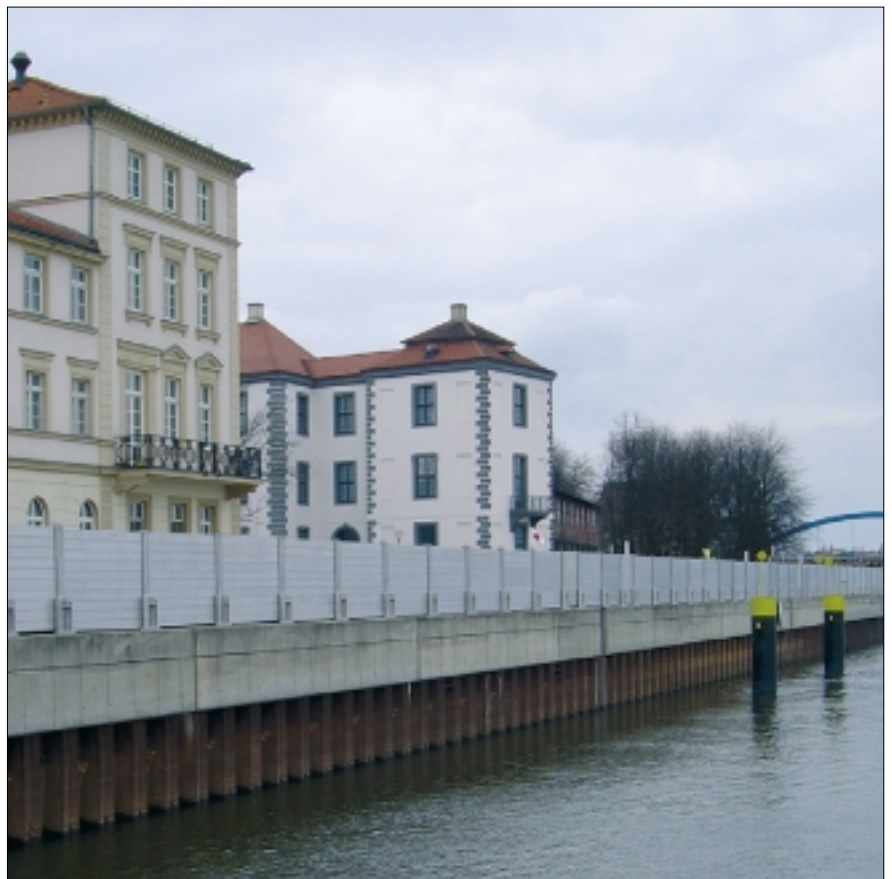
Wenn das mobile Hochwasserschutzsystem aufgebaut ist, können die Anwohner den steigenden Pegel beruhigt beobachten.
