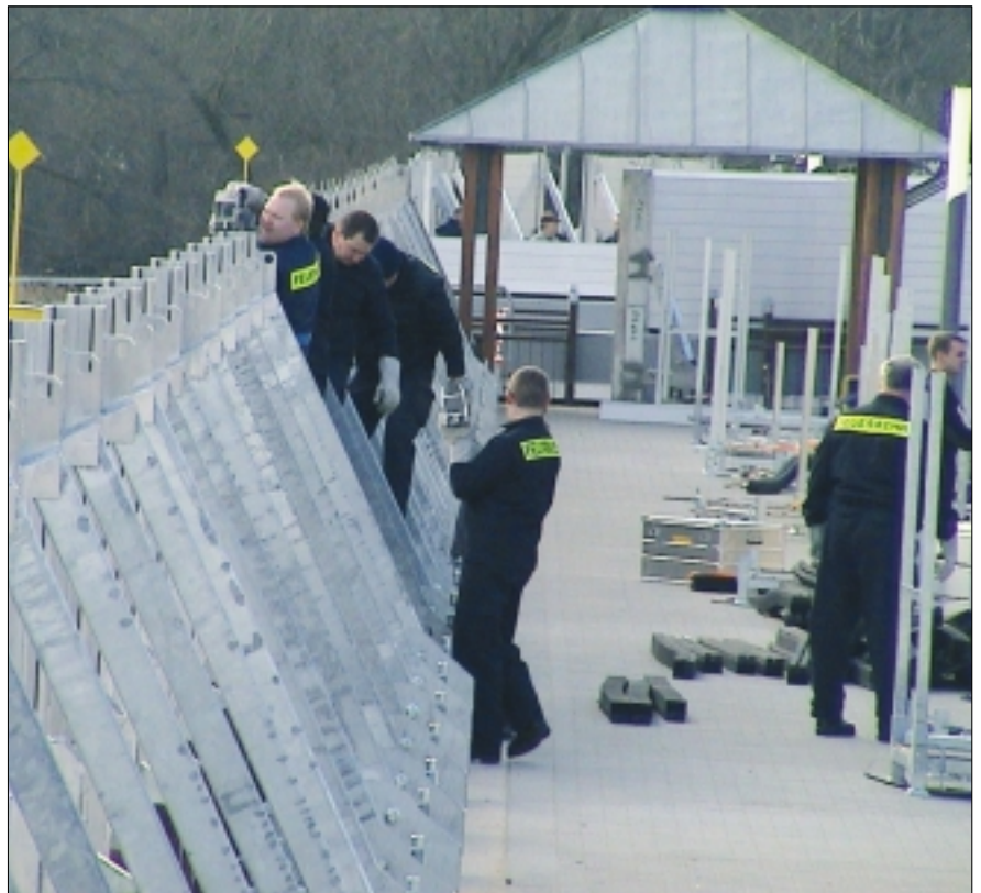
Aufbau des IBS-Systems durch das THW.
