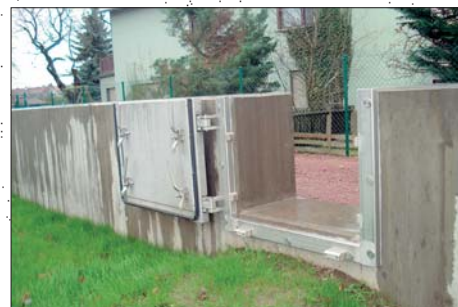
HWT VA geöffnet, auf dreiseitigen Rahmen (oben offen).
