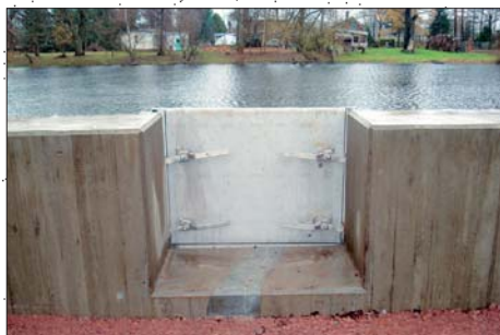
Die Anpressung erfolgt über vier Bügel.
