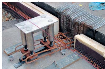
Montage auf Sauberkeitsschicht
