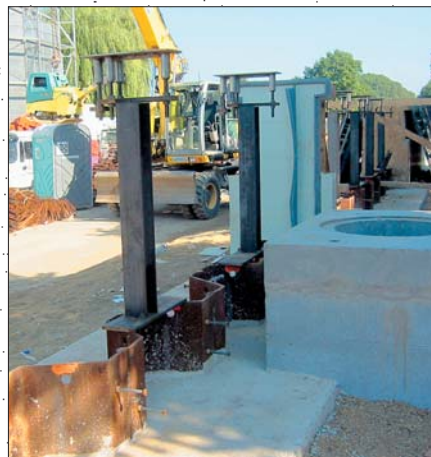
Montage auf Spundwand mit Konsole zur Höhenüberbrückung
