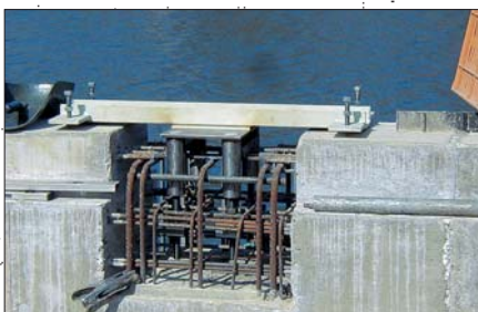
Montage in Aussparung
