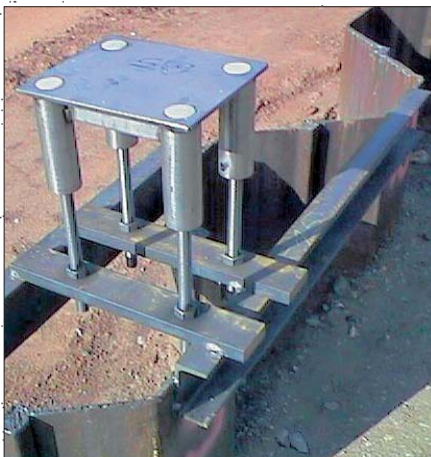
Montage auf Spundwand
