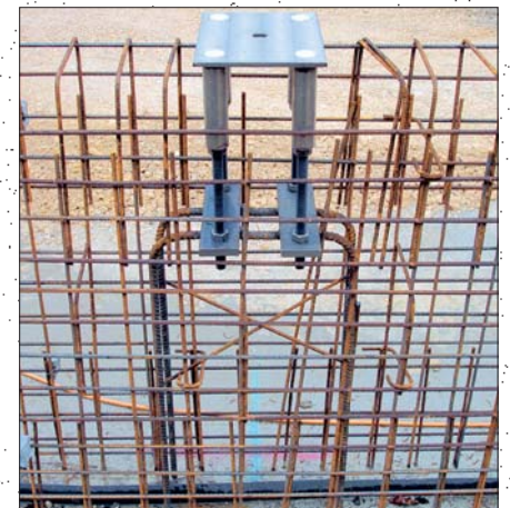
Montage auf Betonierfuge mit Bügel aus Bewehrungsstahl
