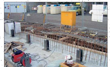
Montage auf Sauberkeitsschicht mit Konsole zur Höhenüberbrückung
