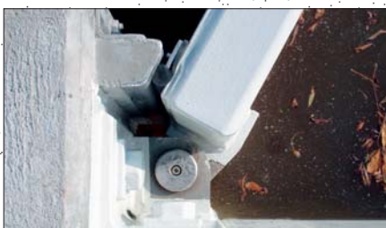
Widerlageranbindung und Dichtlinie.
