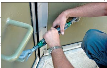
Aktivierung der Dichtwirkung durch Ver-spannen.
