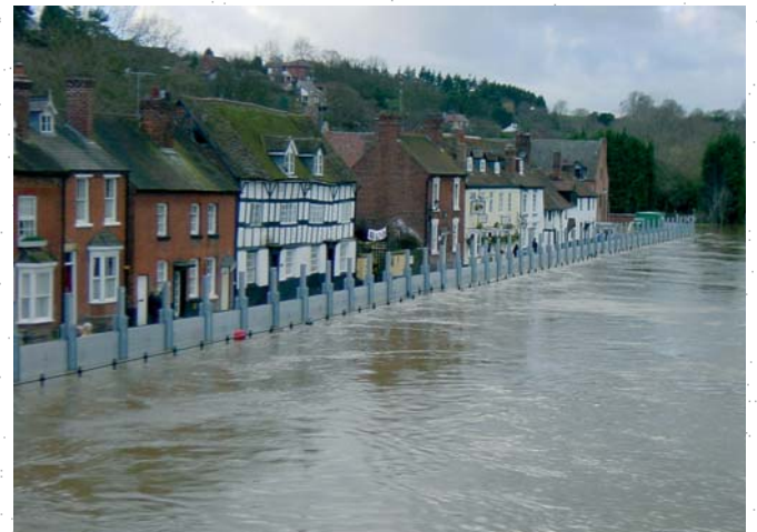
Steigendes Hochwasser wird effektiv zurückgehalten.
