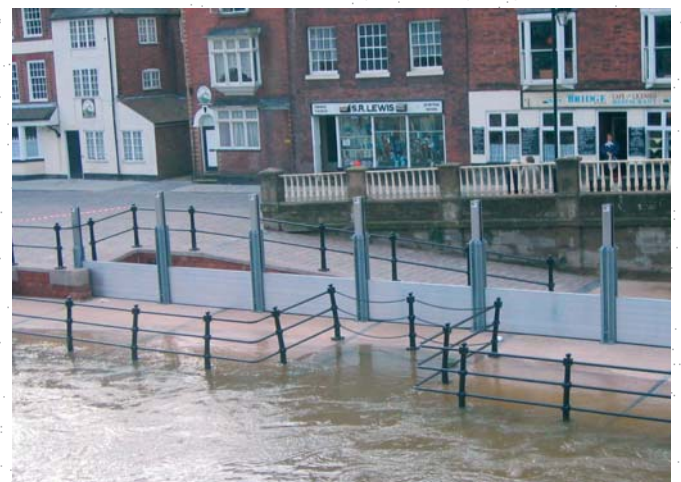
Nach Einbau der unteren Dammbalken kann die Schutzhöhe schrittweise erhöht werden.
