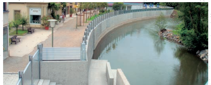
Bereich nördliche Lindesmühlpromenade
