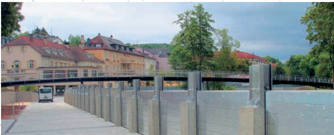
Blick von der Wandelhalle zum Luitpoldsteg
