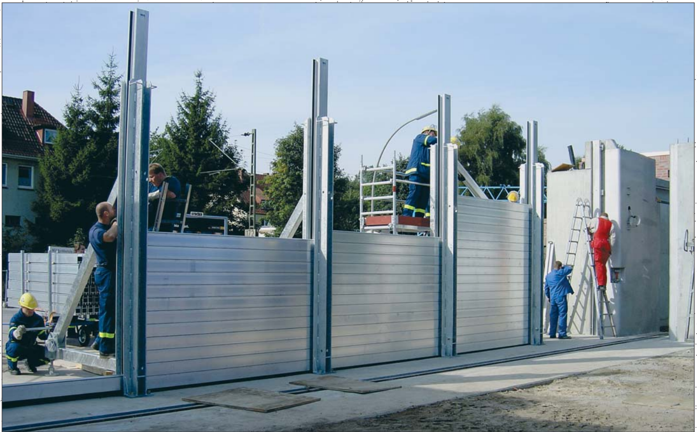
Probe-Aufbau des mobilen IBS-Hochwasserschutzsystems in Hamburg.
