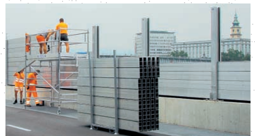
In zwei Aufbauphasen werden pro Feld mit nur zehn Dammbalken 2,50 m Wandhöhe erreicht.
