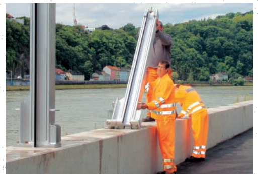
2,50 m hohe Stützen werden von Hand aufgestellt.
