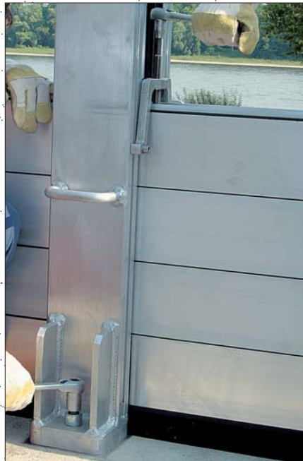
Verschrauben von Stützfuß und Verspannschlitten
