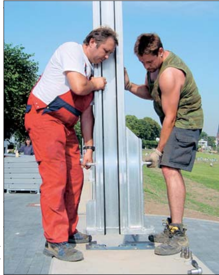
Zwei Mann tragen eine Mittelstütze. Stauhöhe 2,10 m
