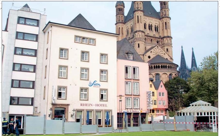
Einweihung der neuen HWS-Wand im Bereich der Kölner Altstadt
