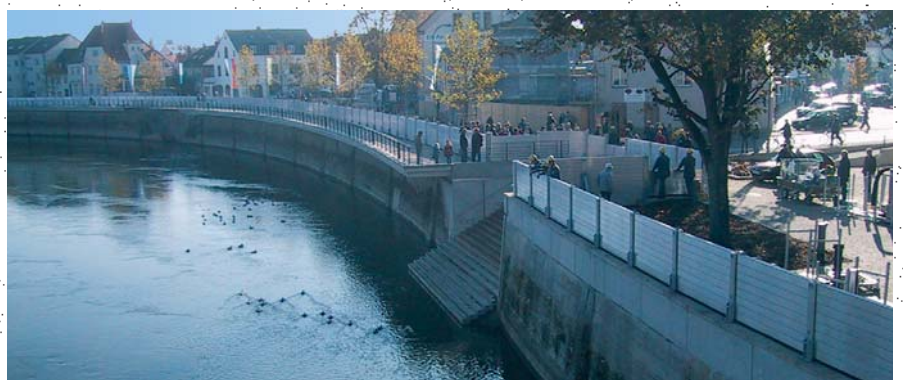
Entlang der Donau ist der mobile Hochwasserschutz aufgebaut.
