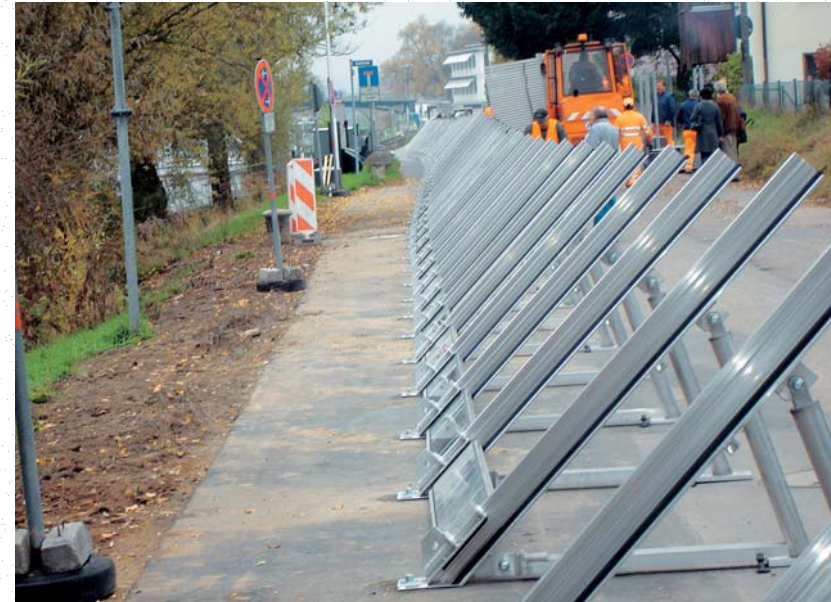
Befestigungssituation: K-Bock mit in die Straßenoberfläche integriertem, wasserseitigen Erdnagel verschraubt.
