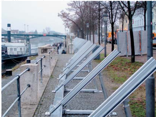
IBS-System im Aufbauzustand K-Böcke und erster Dammbalken mit Bodendichtung.
