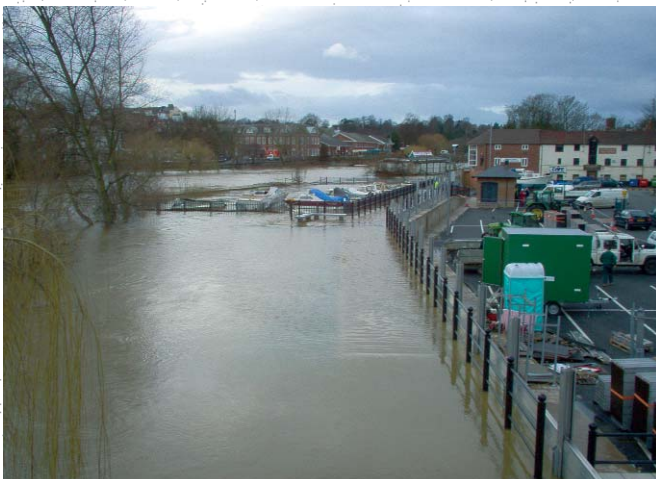
Die neue Hochwasserschutzanlage schützt Stadterneuerungsgebiete.
